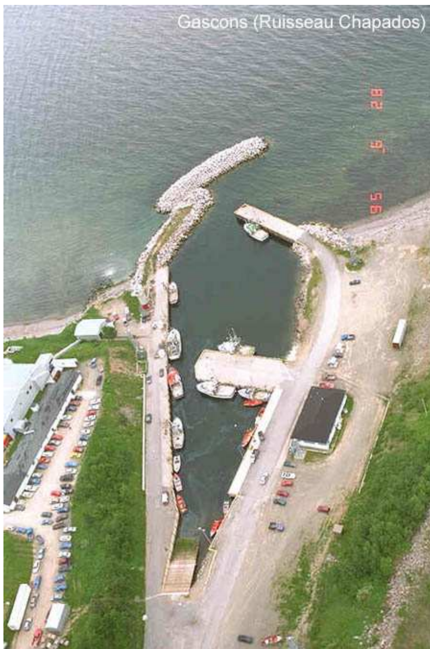
Photo 4 : Havre de pêche de Port-Daniel-Gascons (Gascons, Ruisseau Chapados)
